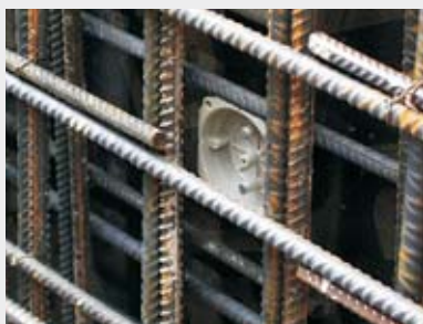
A zsaluzatra erősített KBV fedél.
