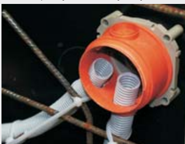
A KBT palástjába szerelt hajlékony csövek.
