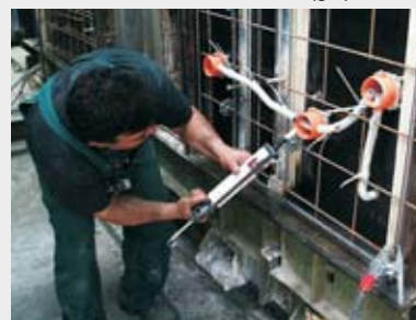
Az átvezetések tömítése (gitt).
